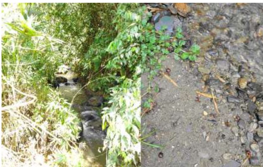
Figura 15. Aspecto del punto de monitoreo 2, Quebrada La Yaruma.
