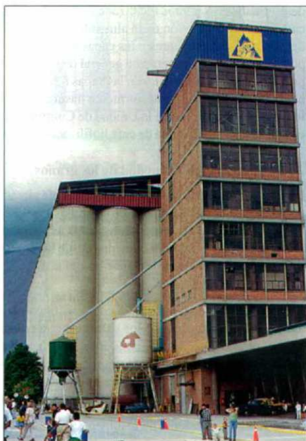
Figura 4. Batería de 60 silos de 30m de altura y 6m de diámetro, para el almacenamiento de café pergamino con aireación forzada nocturna. Foto: Cortesía Almacafé, Bello, Antioquia.
