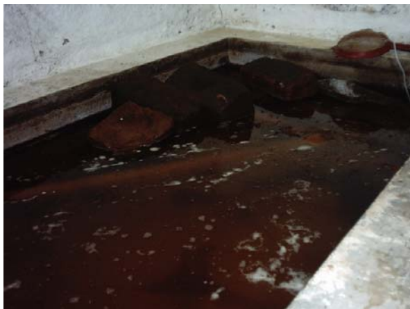
Tanque de esterilización en frío
