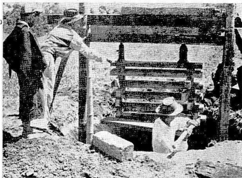
Forma de enterrar los cilindros metálicos con ayuda de gatos hidráulicos.
