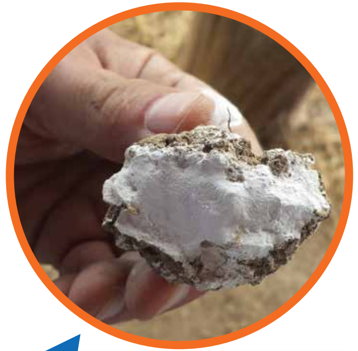
Figura 11. Capas o costras de cal por una aplicación incorrecta.
