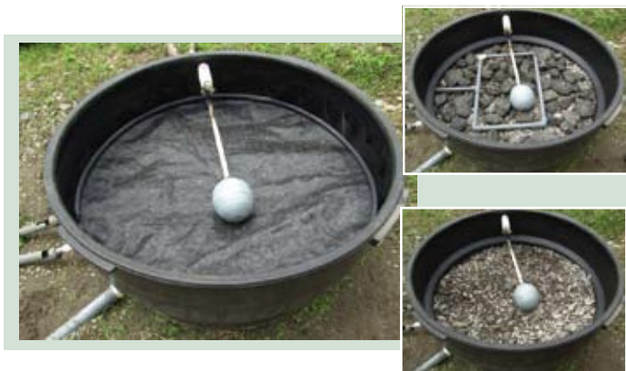
Figura 11. Acondicionamiento interior de la recámara de dosificación.
