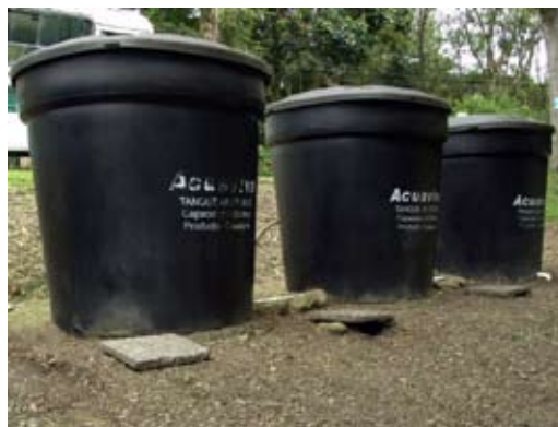
Figura 4. Reactores Hidrolíticos-Acidogénicos en tanques de polietileno.
