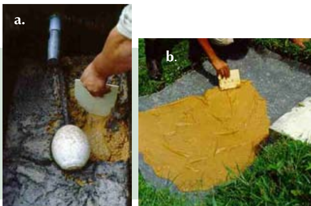
Figura 20. a. Material insoluble retenido en la recámara dosificadora, b. Disposición.
