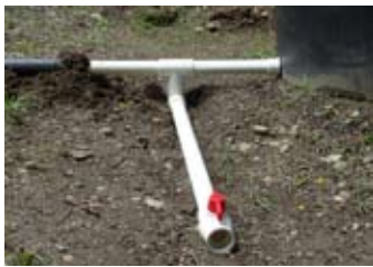
Figura 3. Válvula para purga de aire o gas.
