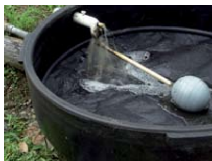
Figura 12. Llenado de la recámara de dosificación.
