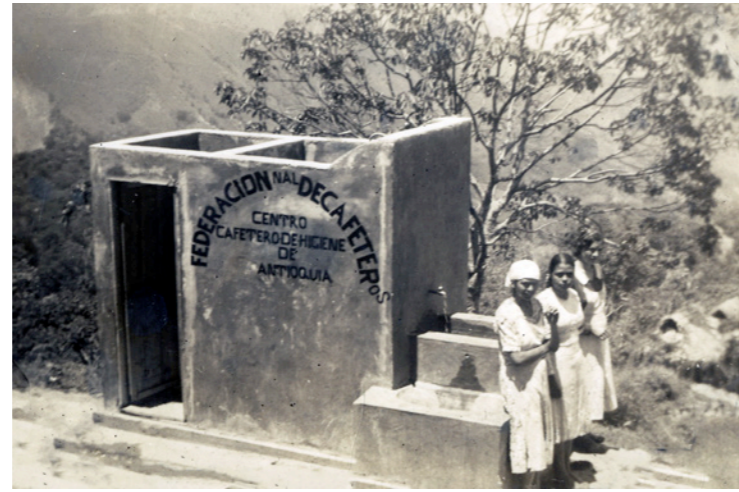
“Acueducto rural de “La Loma”, municipio de Fredonia”, Antioquia, década de 1940. Construcción de tanques de captación y distribución de agua; red de tuberías e instalaciones para agua; dos baños y dos lavaderos públicos que benefician a 36 casas. Los interesados en la obra aportaron para los materiales $281.50 pesos y la FNC $5.828.21 entre materiales y jornales. Campaña de Higiene, Álbum de fotografías, p. 1. Archivo Fotográfico, Comité Departamental de Cafeteros de Antioquia.
