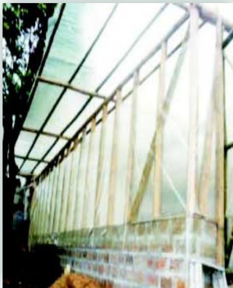
Figura 1. Acondicionador de pulpa de café. Se observa el vuelo exterior de 1,50cm de ancho.
