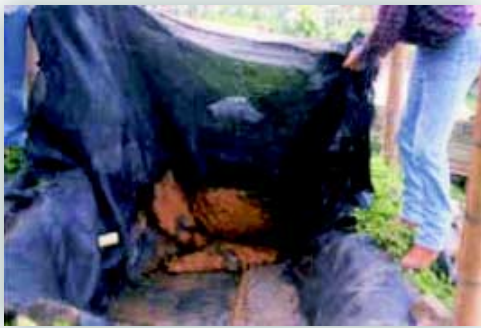
Figura 12. Lecho de Secado. Descarga de lodo proveniente de la Unidad de Control de Insolubles
