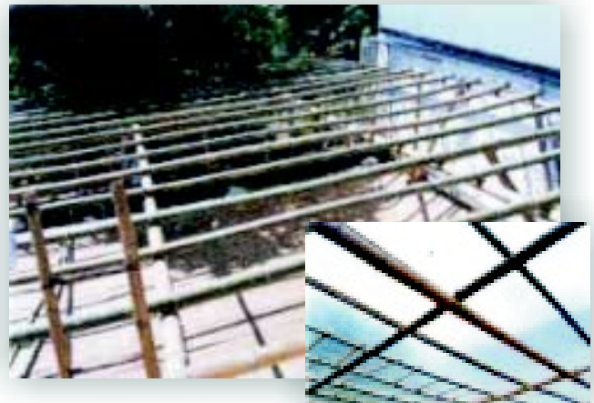
Figura 6. Guadua utilizada en la construcción del techo de AP.
