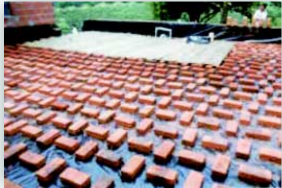
Figura 4. Se colocaron las hileras sueltas de ladrillos de arcilla para soportar el piso de esterillas en tendido doble cruzado
