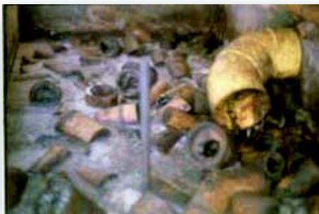
Figura 8. Unidad de control de insolubles en operación
