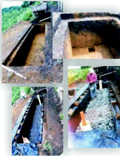
Figura 14. Empacado del filtro preacidificador con «piedra de mano» y piedra caliza de 5 cm de diámetro
