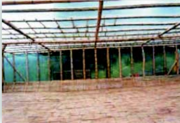
Figura 5. Interior de AP. Techo y paredes en plástico para producir efecto invernadero.
