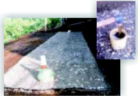
Figura 15. Entrada de lixiviados sobre al FP.
