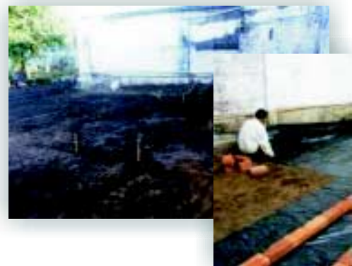
Figura 2. Preparación del terreno en acondicionador de pulpa. Impermeabilización del piso con plástico agrolene
