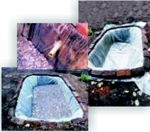
Figura 11. Lecho de secado.
