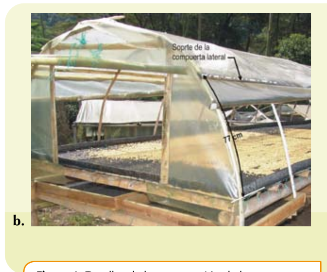
Figura 4. Detalles de la construcción de las compuertas laterales: a) Compuerta fijada a los arcos; b) Distancia sobre los arcos para fijar las compuertas laterales.
