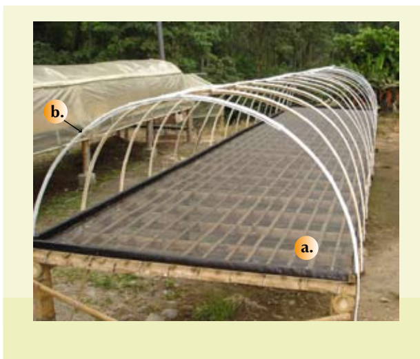
Figura 3. a) Piso en malla Sarán, b) Arcos que forman la estructura para soportar la cubierta plástica, reforzados en la parte interna y sujetos en la parte superior con el caballete.
