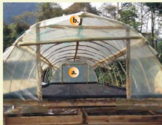
Figura 7. a) Compuertas frontal y posterior; b) Aberturas para la salida del aire húmedo.
