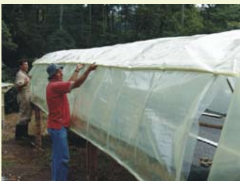
Figura 6. Construcción de la cumbre: a) Fijación del primer lado y preparación para extender el plástico; b) Cubrimiento y templado del plástico.
