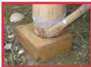
Base en ladrillo
