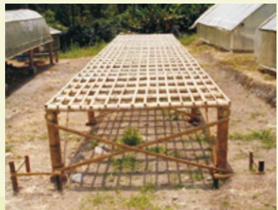
Figura 2. Detalles de la construcción del piso del secador. Entramado con latas de guadua.
