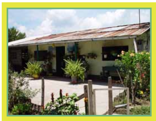
Figura 6. Canalización de aguas de techos e instalaciones.
