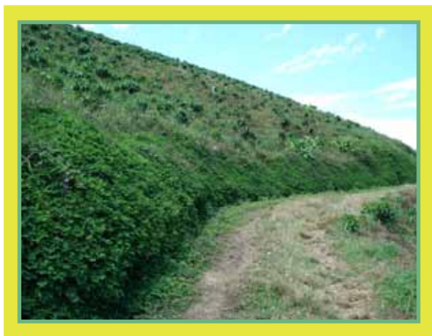
Figura 14. Protección de taludes.
