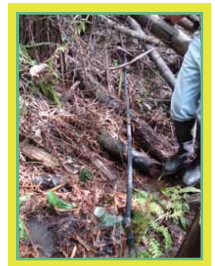
Figura 8. Revisión de mangueras y conductos de agua.
