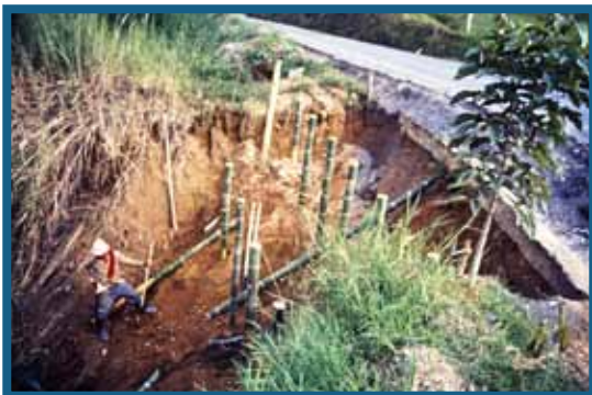
Figura 9. Secuencia de restauración de la banca de la carretera con obras de bioingeniería (filtros y trinchos vivos). Se observa inicialmente el área totalmente anegada. Cenicafé Planalto, 1996.
