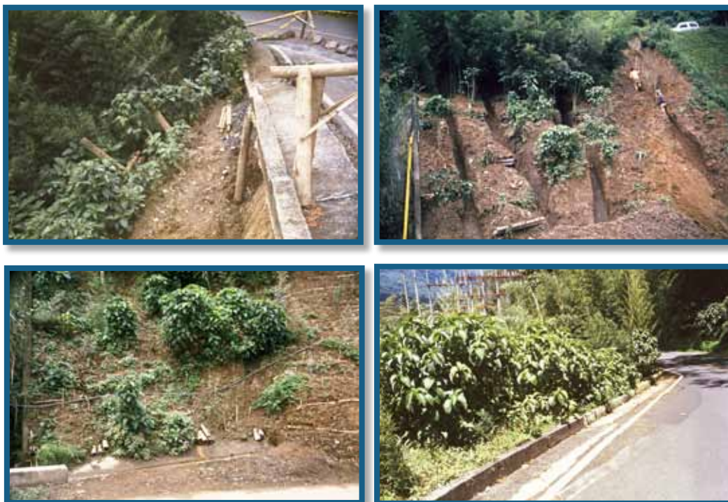
Figura 6. Sistema de manejo integral y sistémico de aguas superficiales y subsuperficiales, con trinchos vivos escalonados y filtros vivos en espina de pescado, respectivamente. Se observa la estabilización rápida del terreno en sólo seis meses (Octubre 3 de 2008). Vereda Balmoral, Filadelfia, Caldas.
