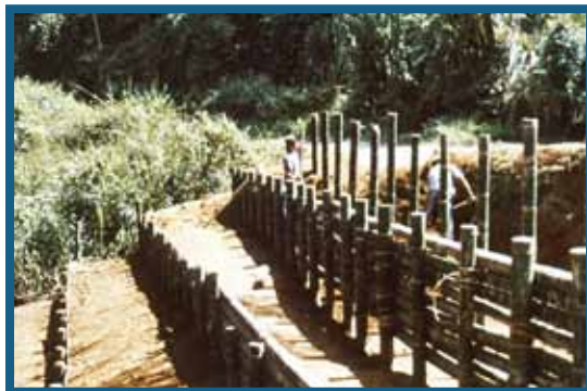
Figura 9. Secuencia de restauración de la banca de la carretera con obras de bioingeniería (filtros y trinchos vivos). Se observa inicialmente el área totalmente anegada. Cenicafé Planalto, 1996.
