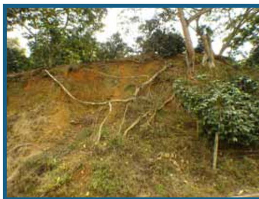
Figura 2. Sistema de raíces de la vegetación arbórea, la cual permite anclaje mayor en lo profundo y hacia los lados en el perfil del suelo. Se observa la exuberancia del sistema radical de un árbol de guamo cafetero, Inga spp.
