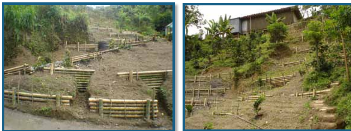
Figura 6. Sistema de manejo integral y sistémico de aguas superficiales y subsuperficiales, con trinchos vivos escalonados y filtros vivos en espina de pescado, respectivamente. Se observa la estabilización rápida del terreno en sólo seis meses (Octubre 3 de 2008). Vereda Balmoral, Filadelfia, Caldas.
