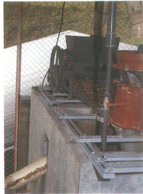
Figura 3. Aspecto general del sistema: carcavo, despulpadora horizontal, canal abierto para transportar café en baba.
