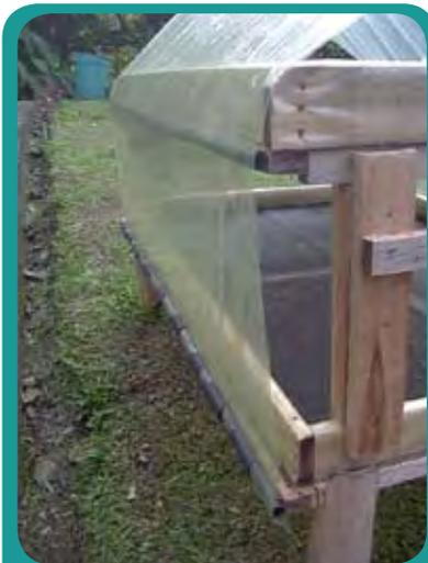
**Figura 11.** Sujeción del plástico en la pasera simple.
