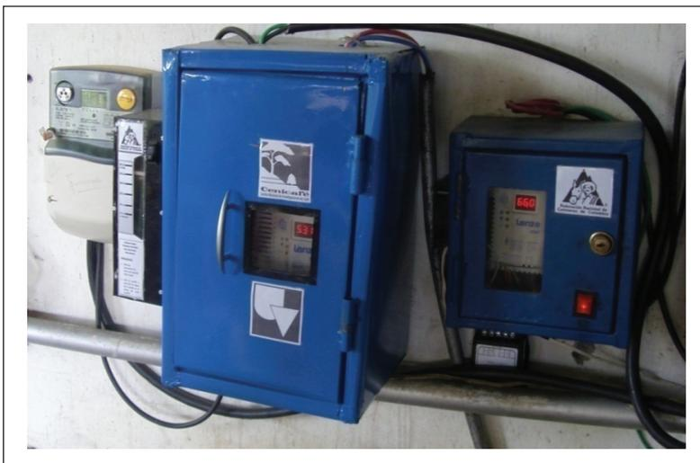
**Figura 6.** Sistema de control simultáneo de caudal y temperatura de secado.
