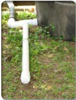
Figura 30. Dispositivo de entrada al reactor metanogénico.
