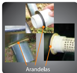
Figura 17. Ubicación de las arandelas de "neolay" entre las paredes del tanque y los dispositivos instalados.
